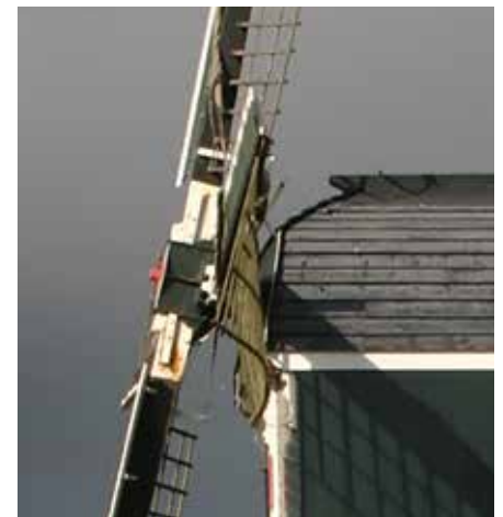
Afbeelding 3: Zijaanzicht van de Oukoper Molen in Nieuwersluis. In het hekwerk van de horizontale roede is duidelijk een bolling te zien.
