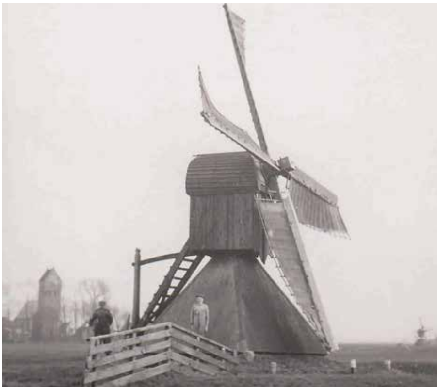
Afbeelding 2: Spinnekop bij Lutkewierum met duidelijk een felle sprong in het hekwerk. (Foto uit de oorlogsinventarisatie)
